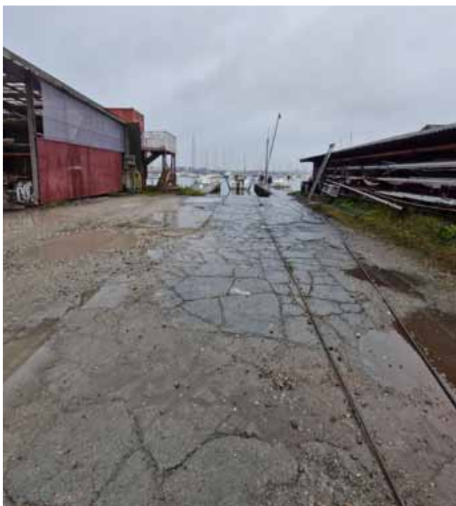
Betonbelægning ved beddingen
